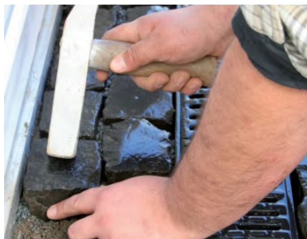
Montāža bruģa segumā
