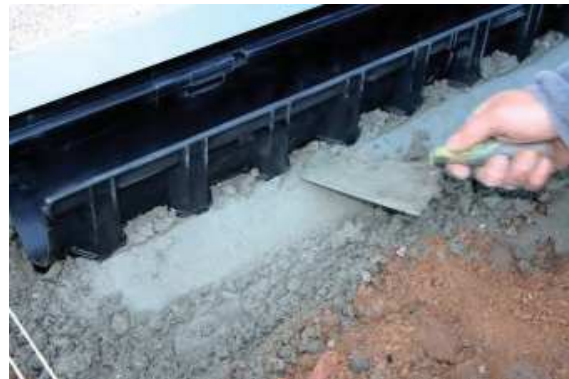
Teknes jāklāj uz betona pamatnes
