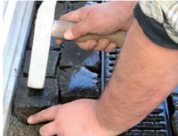
Montāža bruģa segumā
