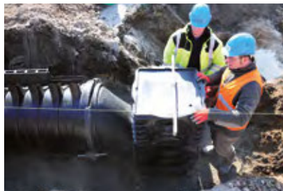
Vadības un drenāžas sifona uzstādīšana
