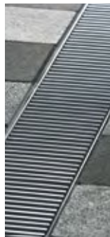
Šķērsprofila režģis Nerūsējošais tērauds
