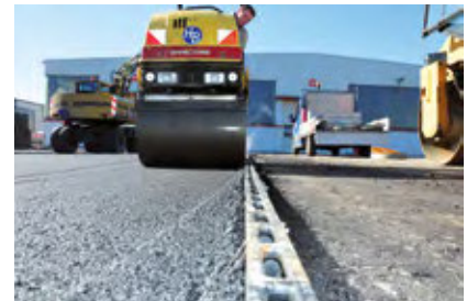
Asfalta slāņa sagatavošana
