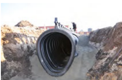
Efektīvs ovālais profils kā uzglabāšanas vietas kanāls
