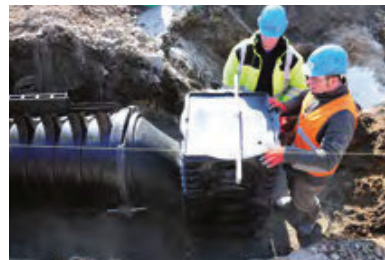
Vadības un drenāžas sifona uzstādīšana
