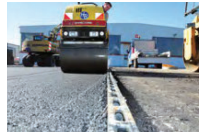
Asfalta slāņa sagatavošana
