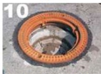
10 insert the manhole frame
