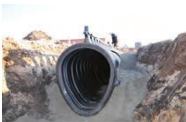
Efektīvs ovālais profils kā uzglabāšanas vietas kanāls
