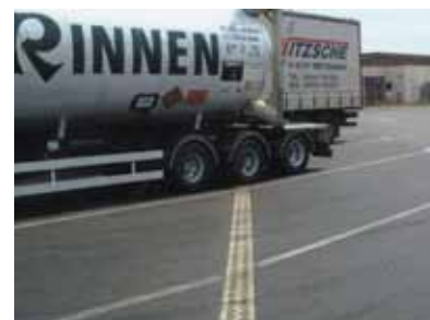
ACO Monoblock RD 200 V kā šķērsā drenāža
